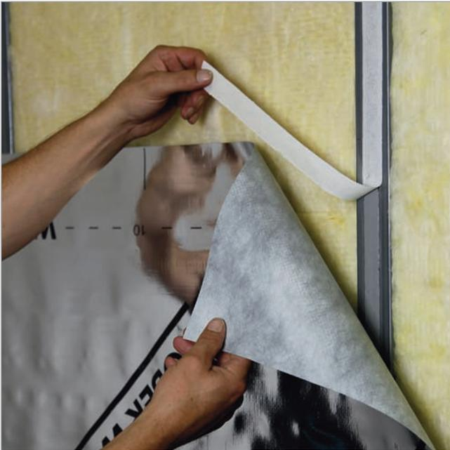
Butylon® шириной 2 см / 5 см склеивает и герметизирует пленки, укладываемые без провисания, а также воздухонепроницаемые пленки на шероховатой поверхности во внутренней и внешней зонах.
