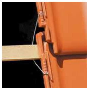
Die Fixierungskerben für die Sturmklammern.
