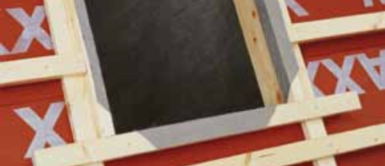
Устройство проёма мансардного окна
